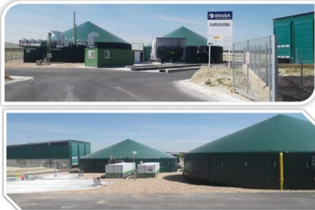
Vista de la Planta de Biogás de ENUSA en la localidad de Juzbado.
